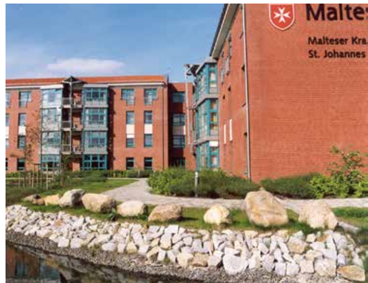
Der Neubau des Malteser Krankenhauses St. Johannes in Kamenz ermöglichte es, eine innovative Krankenhausarchitektur umzusetzen.
